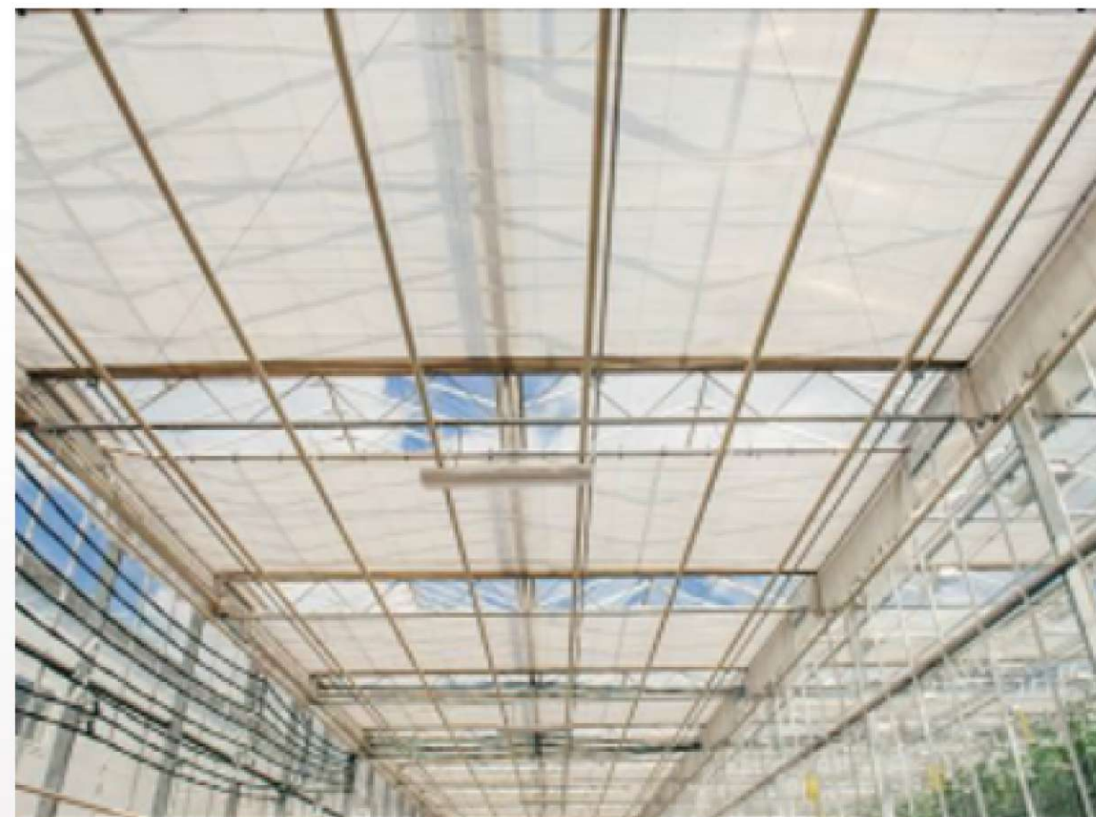
Система отопления комплекса
