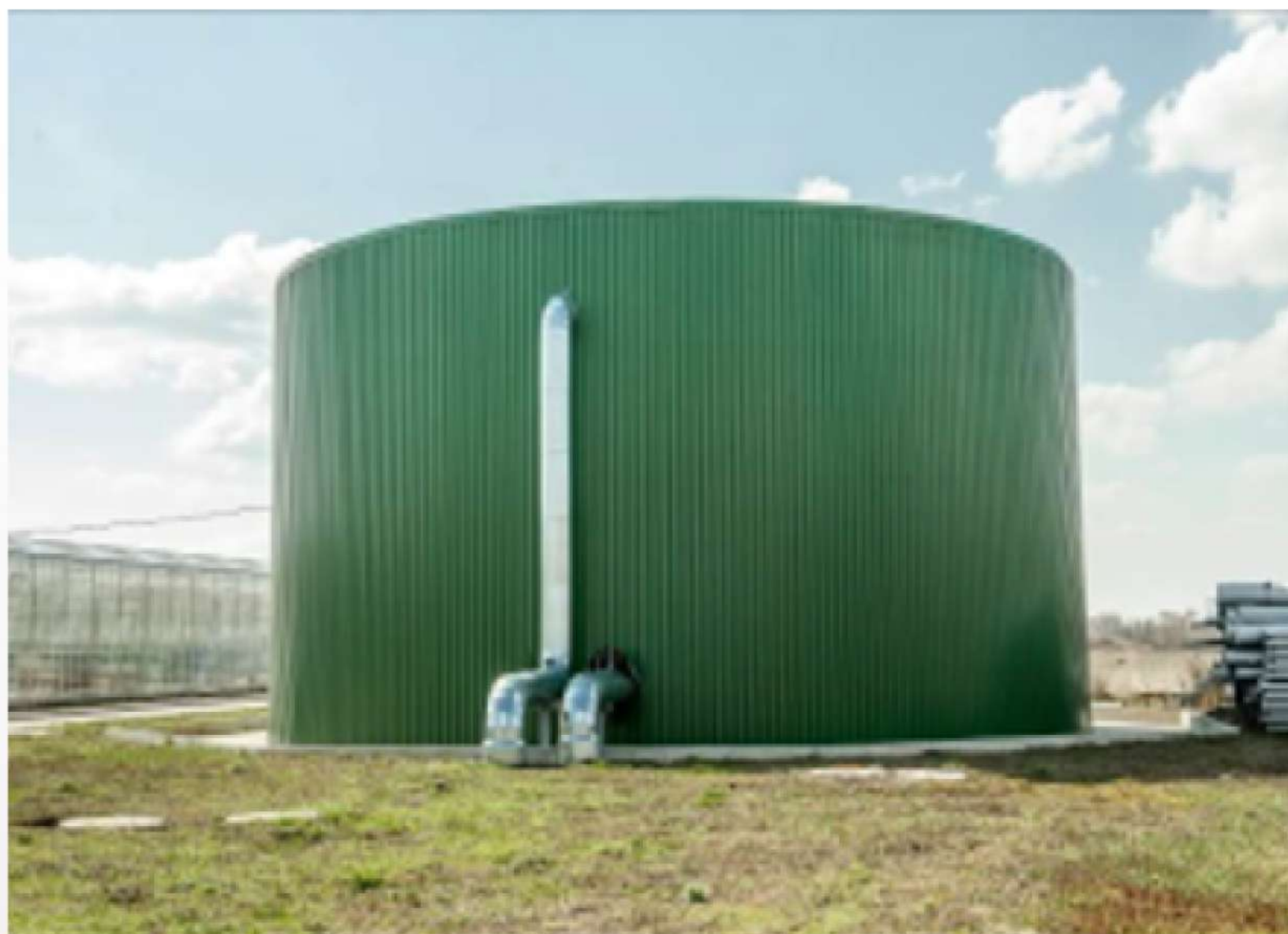
Бак аккумулятор горячей воды
